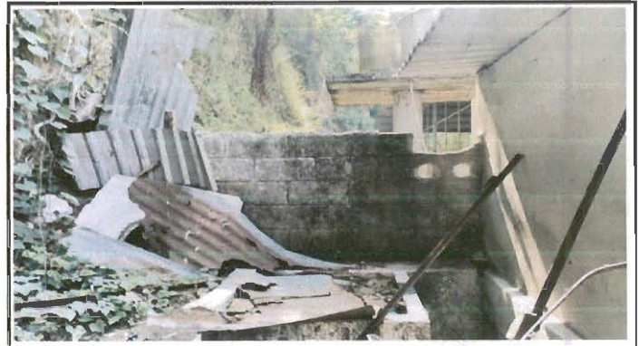
foto 2: REPARACION DE MURO PERIMETRAL
