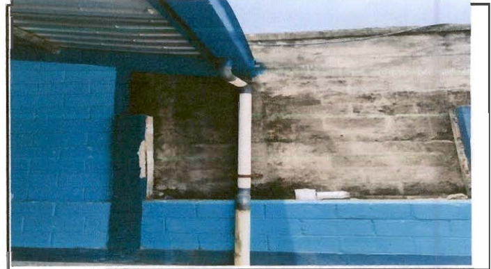
foto 4: SUSTITUCION DE CANAL Y SUSTITUCION DE BAJADA DE AGUA PLUVIAL DE METAL POR TUBO PVC 3"
