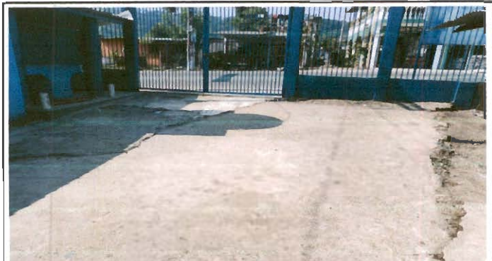
Foto 11: REPARACION DE PLANCHA DE CONCRETO DE PATIO
