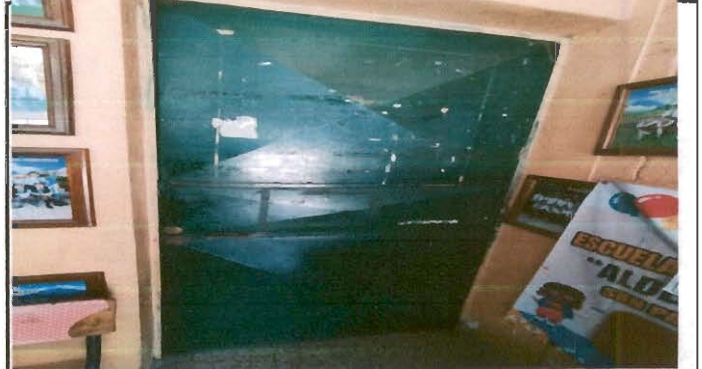
Foto 10 MANTENIMIENTO DE ESTRUCTURA (PUERTA) Y CAMBIO DE CHAPA
