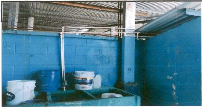
Foto 9: REPARACION DE TUBERIA DE AGUA POTABLE
