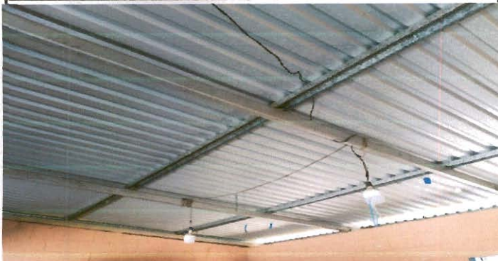
FOTO 7: REPARACION DE PLAFONERAS Y CAMBIO DE FOCOS AHORRADORES
