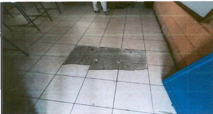
FOTO 5: REPARACION DE PISO CERAMICO
