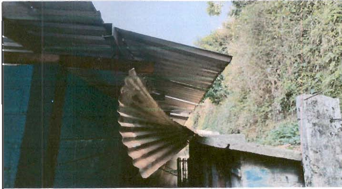
Foto 1: CUBIERTA DE LAMINA Y ESTRUCTURA DE TECHO
