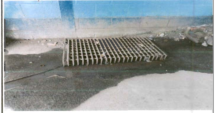
Foto 8: REPARACION DE TAPADERA DE CAJA
