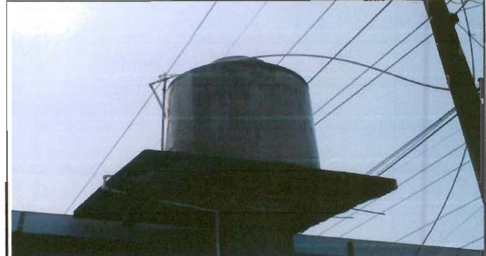
Foto 12; SUS TITUCION DE DEPOSITO DE AGUA 1100 LITROS
