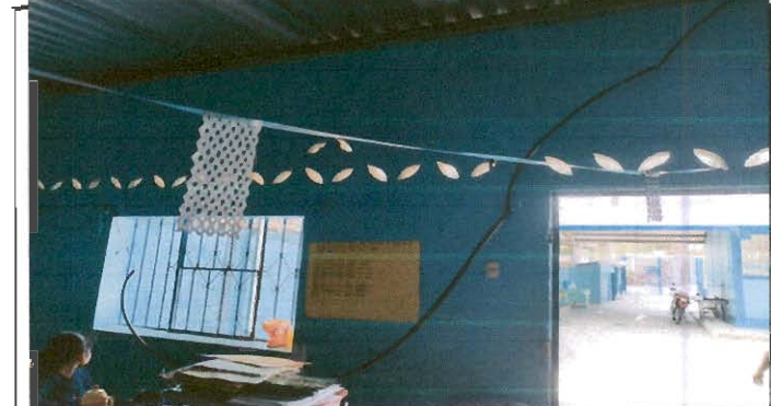
Foto 6: REPARACION DEL SISTEMA ELECTRICO
