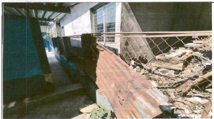
foto 3: REPARACION DE MURO PERIMETRAL
